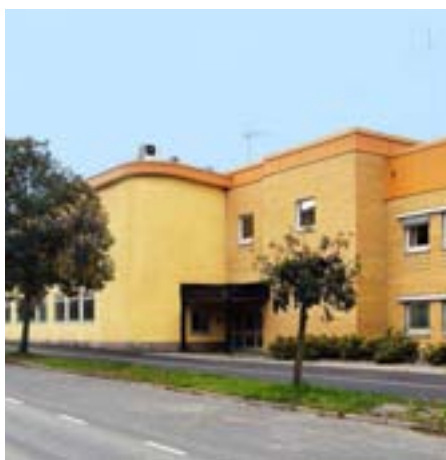
Norrköping Kabeln 1. Klöver tillträdde i mitten av augusti fastigheten som består av närmare 5 400 kvm kontor, lager och verkstad.
