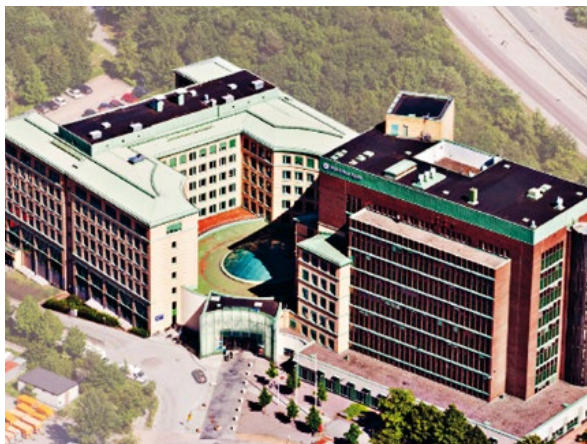
Fastigheten Aprikosen 2 i Solna, mer känd som Solna Gate.
