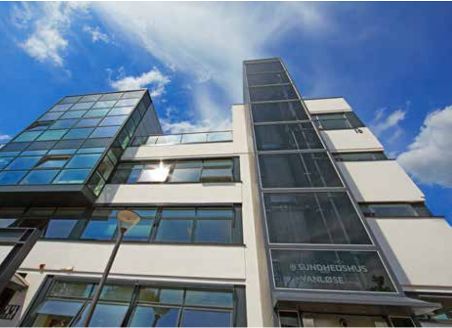
Sundhøtshus (Vanløse) in Copenhagen.
